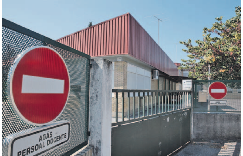
Las obras de mejora energética del CEIP Vilaverde incluyen la retirada de amianto. EMILIO MOLDES
