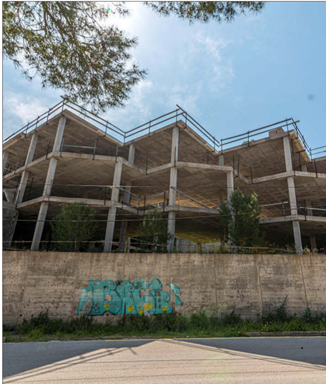
Todas las obras quedan paralizadas a partir de hoy, dentro de las medidas aprobadas por el Gobierno. EFE
