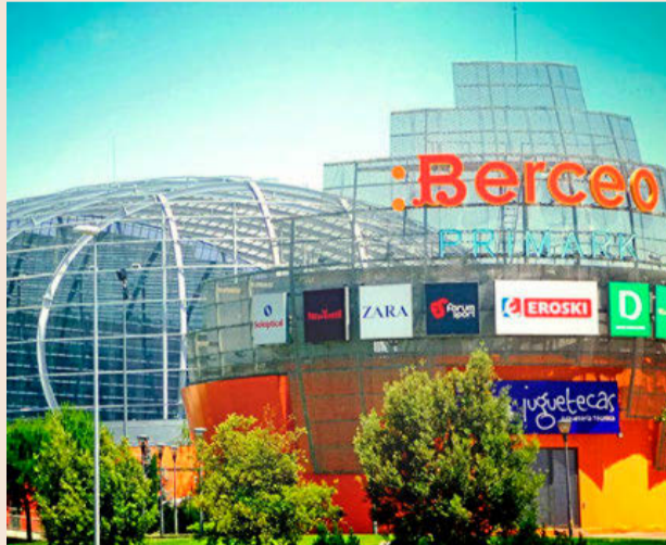
Centro comercial Berceo, ubicado en Logroño.
