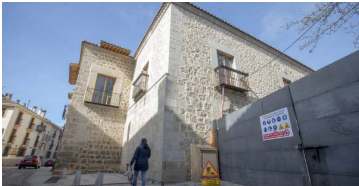
Exterior del Palacio de Los Águila, con señales de obra. / ISABEL GARCÍA (ARCHIVO)
